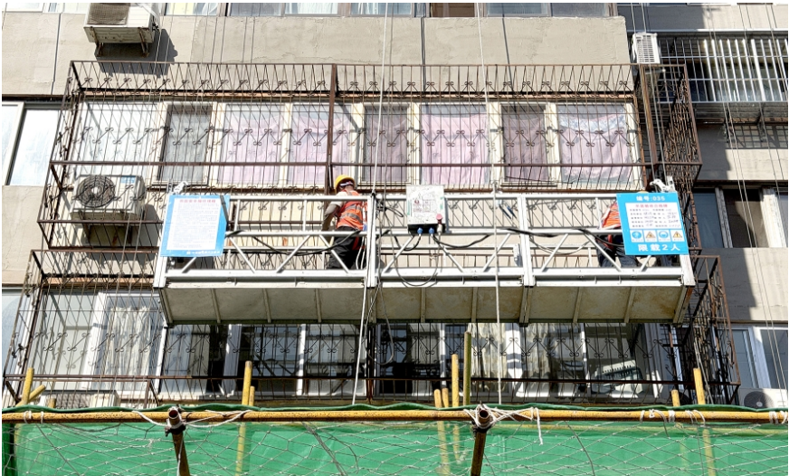
图为10月8日，在北京市朝阳区，工人正对一老旧小区居民楼墙面进行施工作业。
