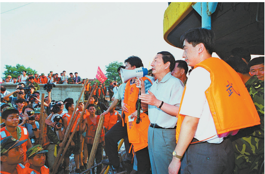
上图:1998年8月9日,朱镕基同志在江西省九江市防洪墙堵口现场指挥抗洪抢险工作。
