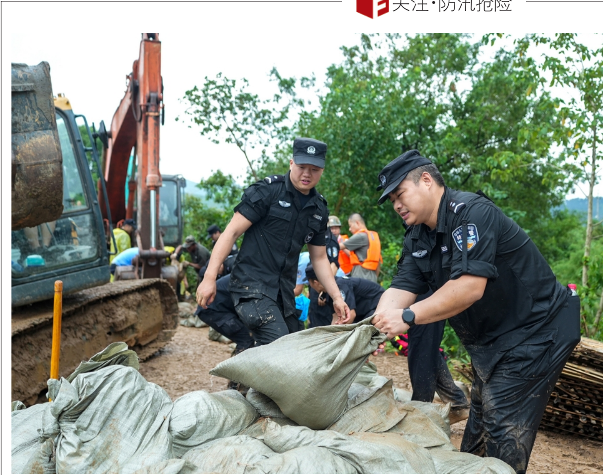
8月11日,浙江省长兴县和平镇出现内涝险情。长兴县公安局巡特警大队、和平派出所迅速启动应急处置预案,联合镇村干部,群众及民力量赶赴一线,全力开展排涝作业、积水疏导与救援保障工作,守护群众生命财产安全。图为民辅警与干部群众奋战在抢险救援一线。
