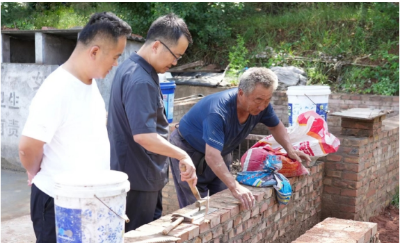
图为张海峰(中)在杨老汉家中查看排水渠修缮情况。
