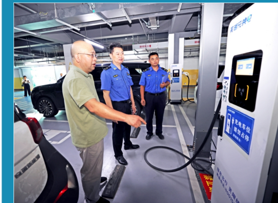
近日,安徽省芜湖市镜湖区司法局联合市场监督管理局等相关部门,在中山路步行街商圈开展“综合查一次”专项行动。图为执法人员在步行街地下停车场,核查无牌停车位设置、新能源充电桩运维状况、停车收费公示牌规范等情况。
