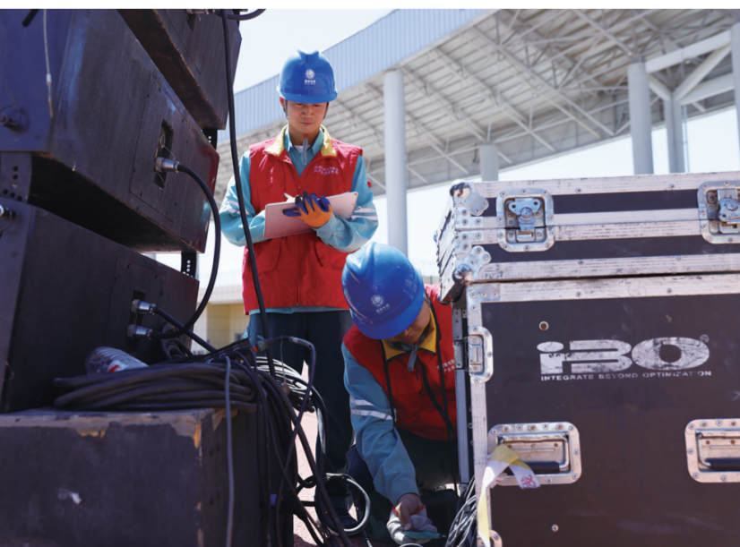
5月至8月,新疆维吾尔自治区举办“同心杯”新疆足球超级联赛。为保障赛事期间供电安全,国网沙湾供电公司组织共产党员服务队,对赛场及周边供电线路、变压器、配电箱等设施开展全面巡检,及时发现并消除安全隐患。图为服务队队员近日检查音响、转播台等用电设备。
