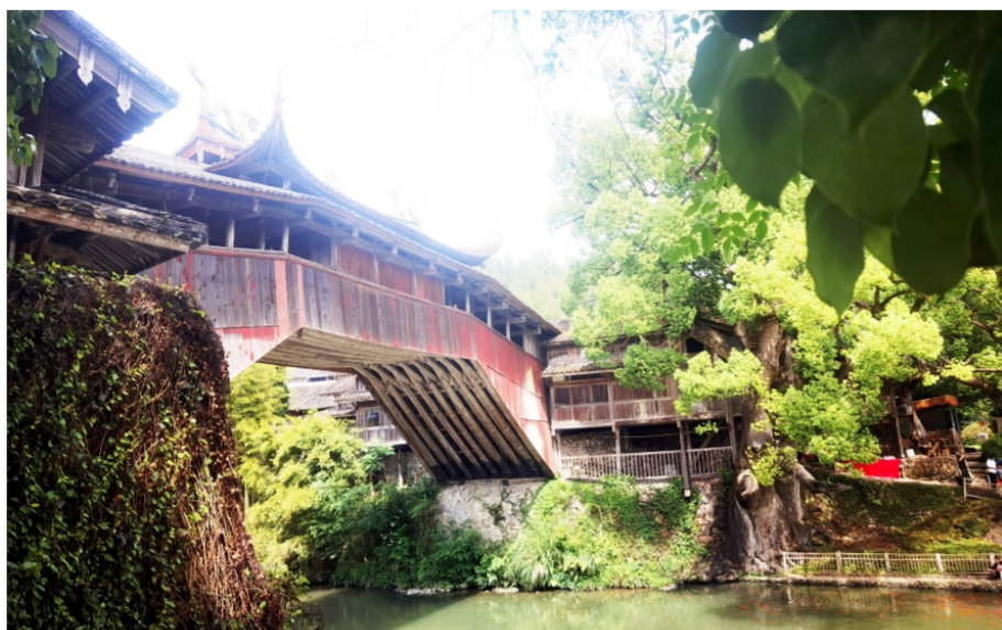
图为位于浙江省温州市泰顺县泗溪镇下桥村的北涧桥。
