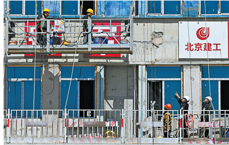
容城县公安局大河派出所民警牛一卓、肖天华走进北京交通大学雄安校区项目工地,对高空作业人员进行安全提示。
