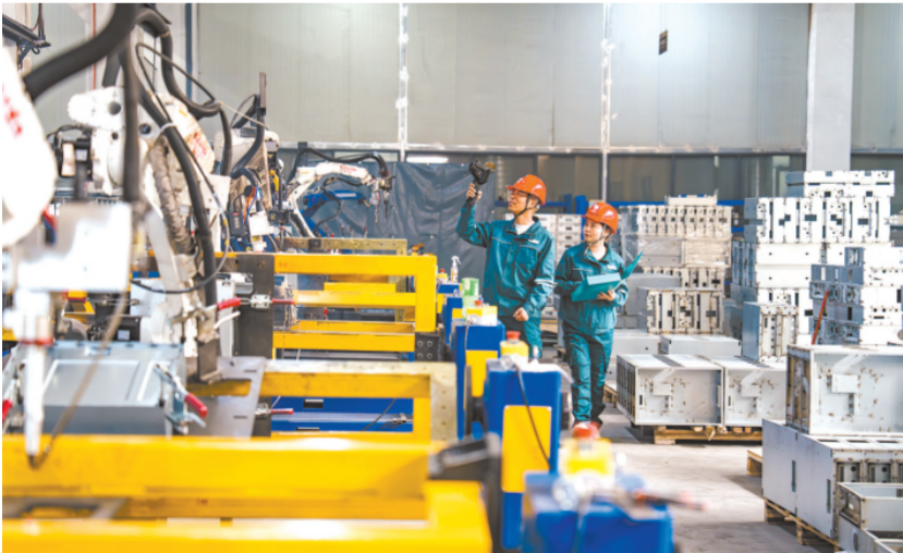
近日，国网宁波市鄞州区供电公司工作人员走进宁波万金精密科技股份有限公司，开展安全用电专项检查。图为供电公司工作人员手持红外测温仪，对车间线路及关键设备进行精准测温，全面排查用电安全隐患。 洪浩哲 摄
