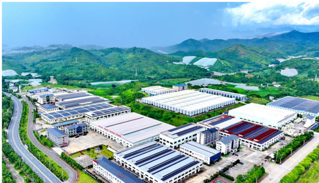
城乡建设领域是碳排放的主要领域之一。图为江西赣州寻乌县石排工业园区物流企业厂房屋顶，太阳能光伏发电板依次排列。
