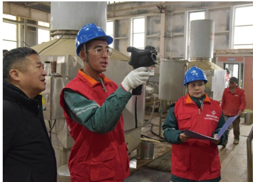
近日,国网奎北供电公司共产党员服务队走进新疆西域酒业有限责任公司,对企业的生产车间、配电箱线路设备等进行“体检”。图为服务队队员使用红外测温仪识别设备温度异常区域,精准查找潜在隐患。
