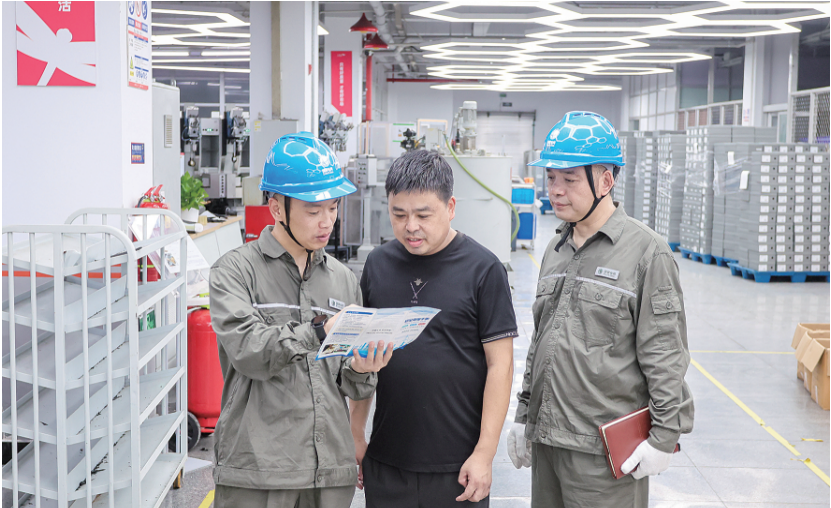
近日，国网温州供电公司组织专业技术团队，对某鞋业公司的配电设施和线路开展全面排查，制定有针对性的“能效诊断+安全用电”一体化服务方案。图为团队工作人员向企业负责人讲解安全用电知识。 周永 摄
