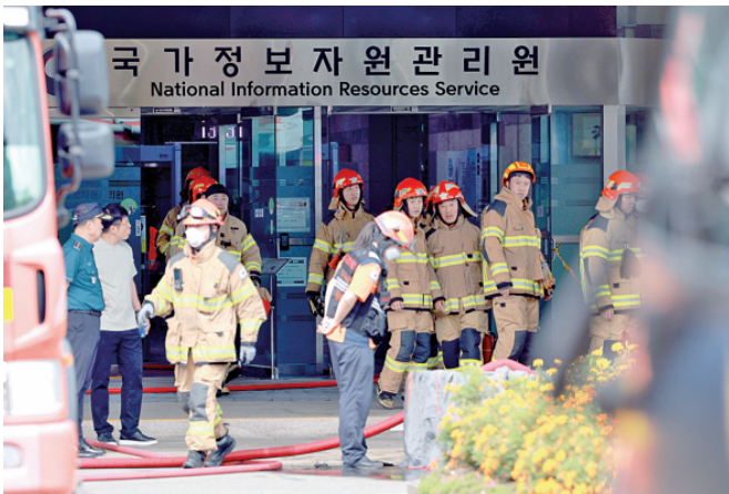
图为9月27日,消防员在发生火灾的韩国国家信息资源管理院检查被烧毁的电池。 CFP供图
