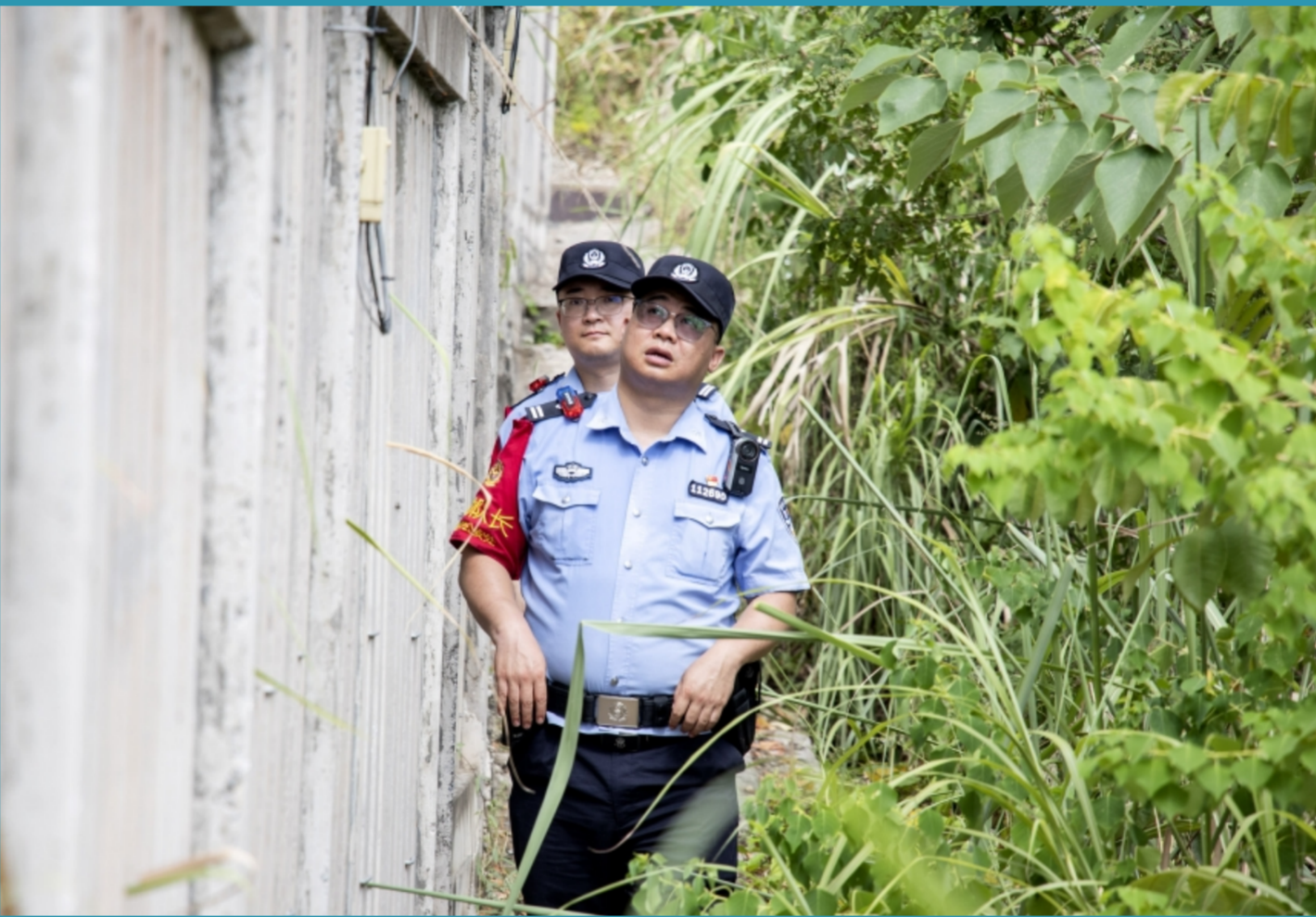
郑渝高铁万州至巫山段，汛期易发边坡塌方、线路积水等险情。近日，成都铁路公安局重庆公安处巫山站派出所民警顶着烈日开展线路隐患排查、铁路安全宣传等工作，切实保障列车运行安全。图为民警对辖区铁路栅栏封闭情况进行检查。
