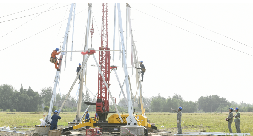
近日，国网荆州供电公司依托自行研发的MT2D06履带式智能组塔装置，在湖北省荆州市镇安寺—观音寺110千伏线路工程开展铁塔组立工作。图为公司员工利用该装置起升机构进行高空攀爬作业。
