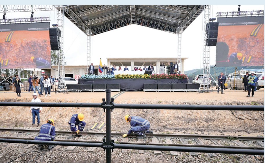
图为6月17日，在哥伦比亚昆迪纳马卡省法卡塔蒂瓦市，工人在项目开工仪式上拆除旧铁轨。 新华社发 安德烈斯·莫雷诺 摄
