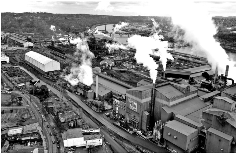
图为美国宾夕法尼亚州，美国钢铁公司位于Edgar Thomson钢铁厂的设备。 (CFP供图)
