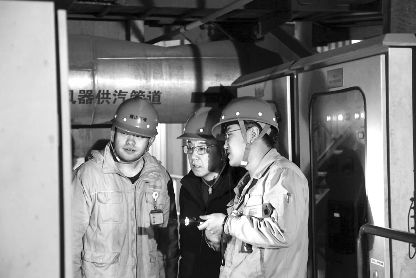
图为记者(中)跟随塔山发电公司员工进行巡检。
