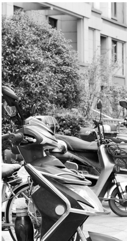
为破解电动自行车充电场所建设“选址难、资金缺、管理乱”等堵点难点，浙江省衢州市柯城区政府近日采取雨棚式和立柱式充电设施相结合的方案破解“落地难题”，让老百姓方便用、放心用、主动用，图为柯城消防部门与物业人员测试立柱式充电桩使用情况。
