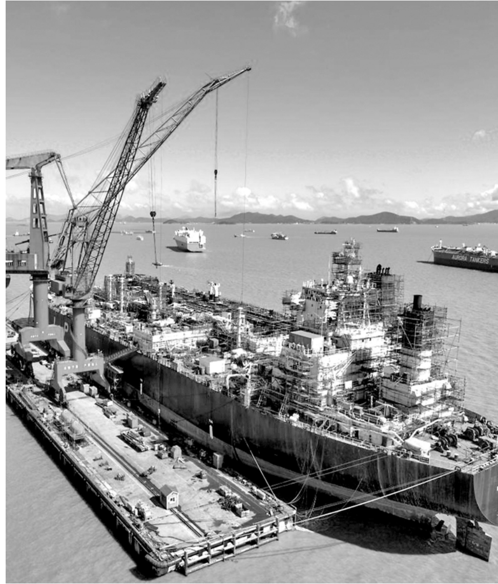
近年来,浙江省舟山市依托良好的区位优势,大力发展船舶修理、船舶制造等产业,出台一系列船舶修造行业专项扶持政策,加大绿色修船装备研发、技改、销售补助力度,推动产业绿色发展。图为近日,在浙江省舟山市普陀区舟山万邦永联船舶修造有限公司内,工人们不惧高温,坚守岗位,正在抓紧维修船舶。 本报通讯员 邹训水 摄
