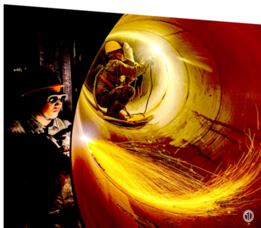
图① 火箭军某部施工骨干在高空进行作业。
