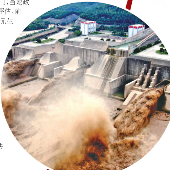
黄河小浪底水利枢纽泄洪场景。
