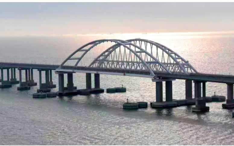
图为连接克里米亚半岛和俄罗斯克拉斯诺达尔边疆区的克里米亚大桥铁路桥。 新华社发
