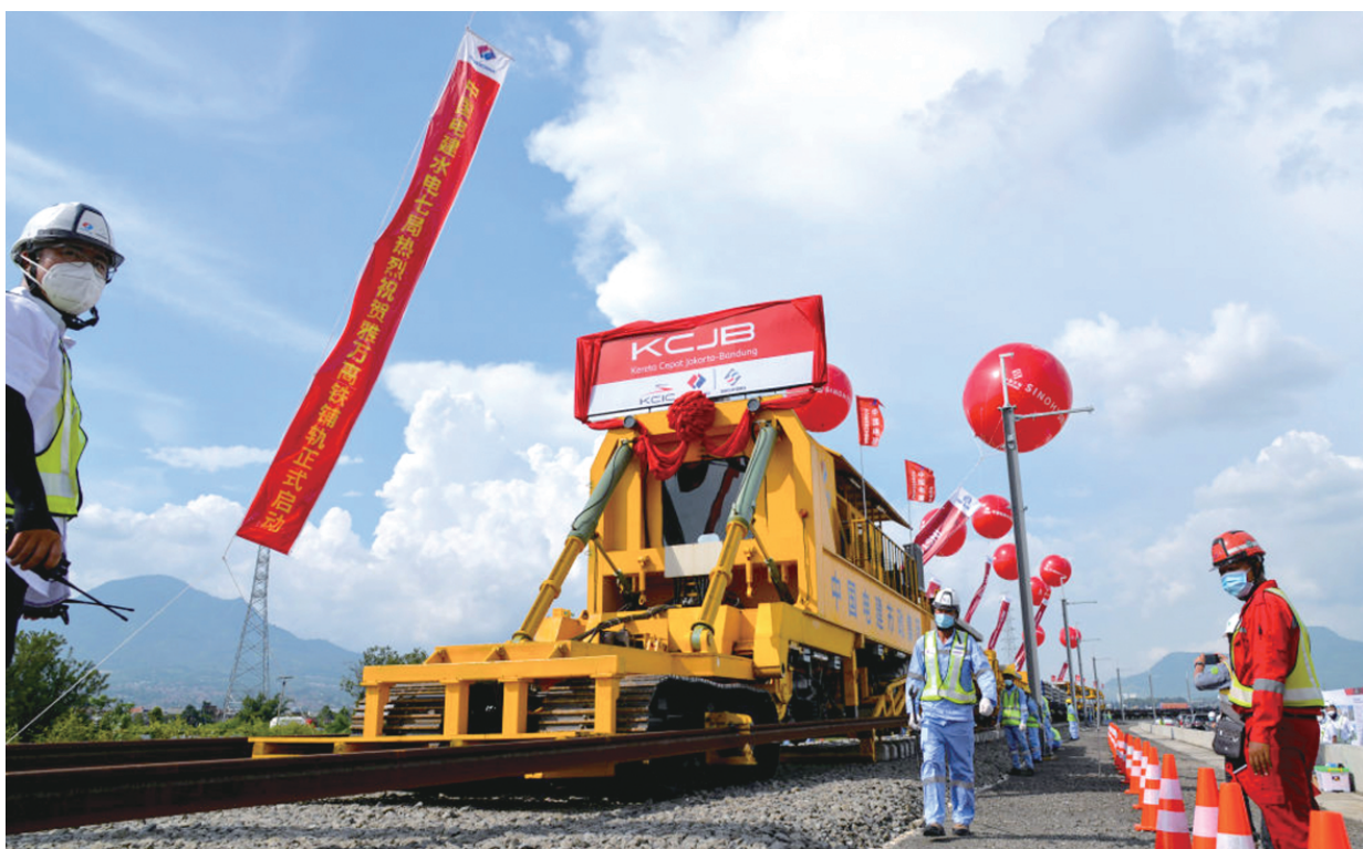
图为2022年4月20日，工作人员在印度尼西亚万隆雅万高铁施工现场启动铺轨作业。当日，雅万高铁开始启动铺轨施工。 新华社发
