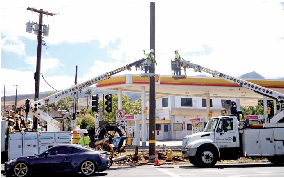
图为8月20日，工人在美国夏威夷州拉海纳修复电力系统。
