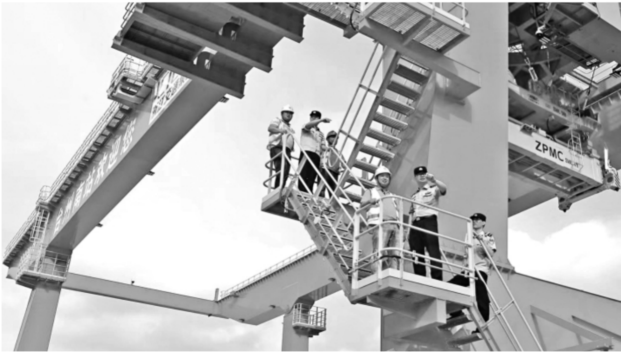
5月25日,杭州铁路公安处台州站派出所民警在台州南铁路智慧陆港新区项目建设现场进行安防指导。 本报通讯员 蒋友亲 摄
