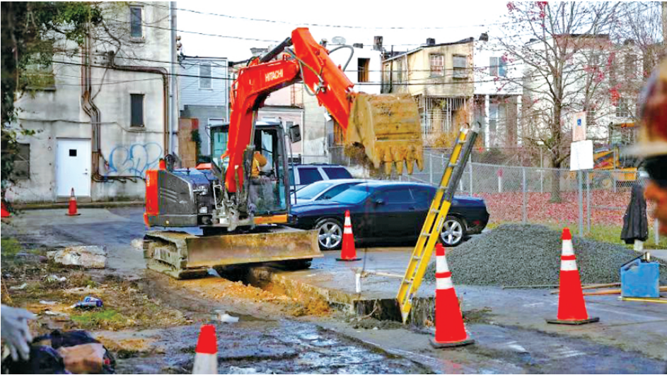
图为工人在维修巴尔的摩的供水管道。资料图片
