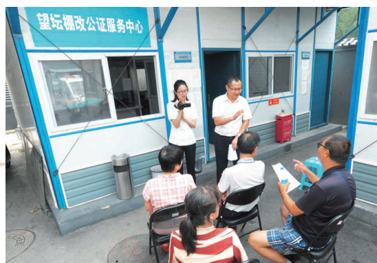
2017年7月31日,北京核心区最大棚改项目——望坛棚改项目工地,公证服务中心工作人员现场为业主办理公证。 本报记者 王建军 摄
