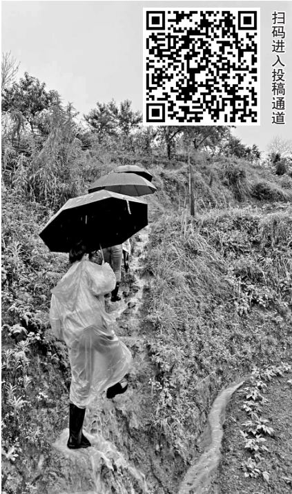
图为刘婷在普光社区西侧山场土松滑坡坡现场开展处置工作。 张坚 摄
