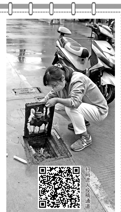
图为吴锦瑾在清理下水管道。 徐新民 摄
