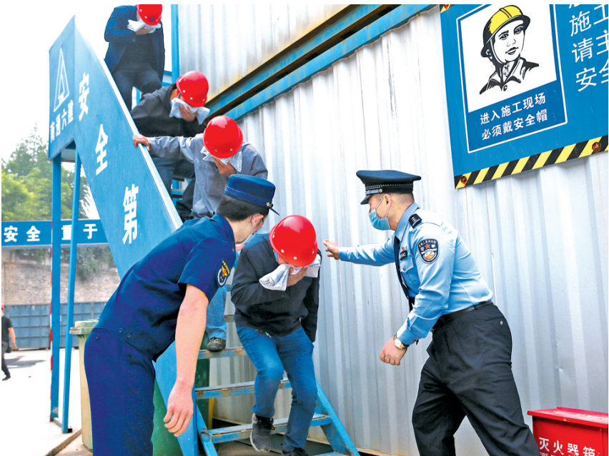
近日，山东省济南市公安局市中分局六里山派出所联合市中区消防救援大队来到辖区工地开展应急避险教育活动，普及消防安全知识，强化工人安全意识。图为组织工人开展消防逃生演练现场。
