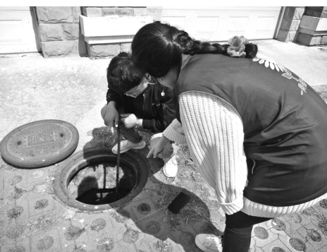
图为崖头街道曙光社区网格员与供热维修人员一起排查漏水点。
