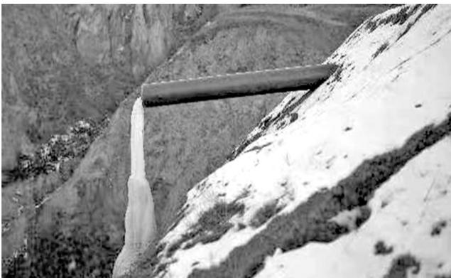
图为2021年12月18日，督察组现场督察发现，宁夏回族自治区西吉县马莲乡垃圾填埋场在渗滤液收集池违法设置溢流管，直排的渗滤液已冻结成一根“冰柱”。督察组供图
