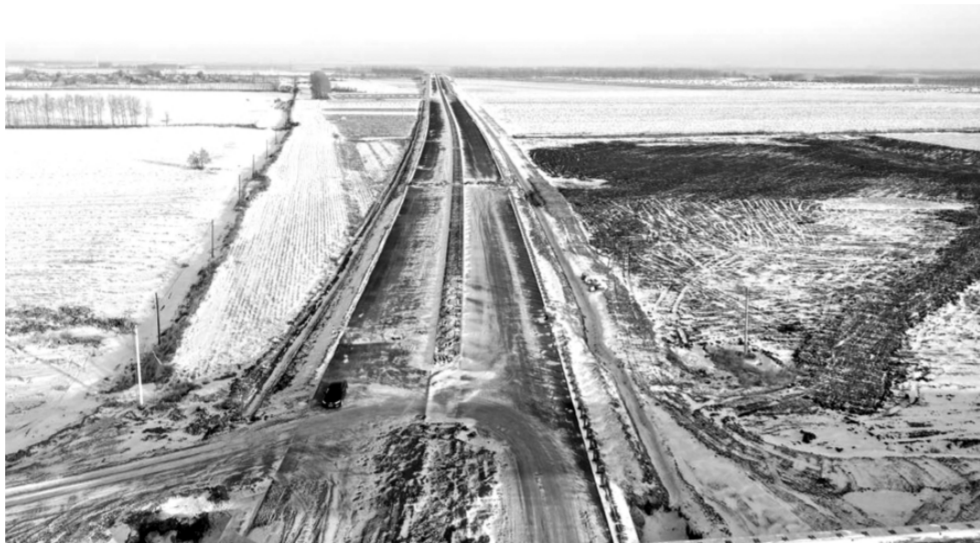
图为2021年12月16日,督察组现场督察发现,黑龙江省绿化市在建的交通项目非法侵占大量黑土耕地。督察组供图
