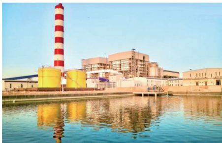
图为由中国能源建设集团广东火电工程有限公司承建的约旦阿塔拉特油页岩电站项目外景。
