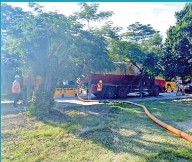
图为大型吸污车正在抽取沙边涌里的黑臭污水。
