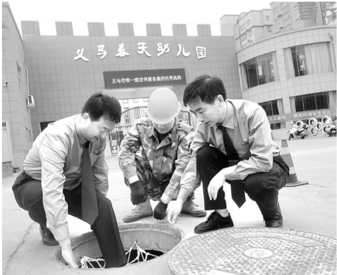
秋季开学后,河南省义马市人民检察院协同有关部门为全市中小学校100米范围内的窞井安装防坠网。图为10月12日,检察干警与施工人员进行防坠网安全检验。
