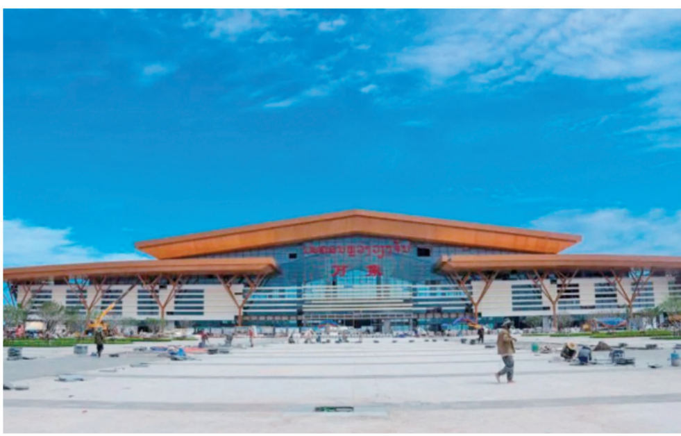
图为10月6日在老首都万象市拍摄的中老铁路万象站。
