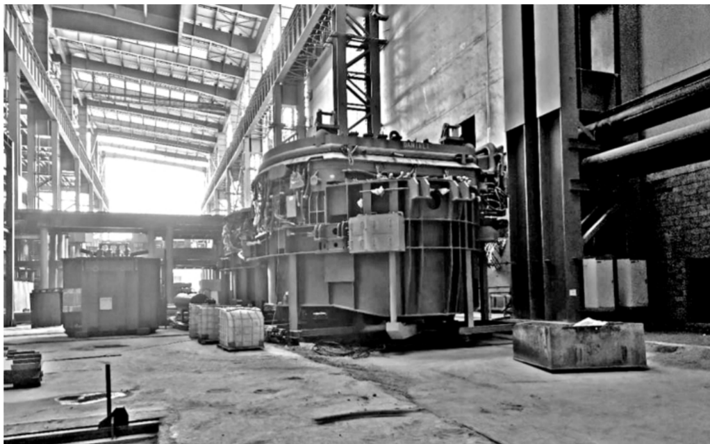
图为2021年9月,督察组现场督察发现金晟兰冶金科技有限公司(二期)违规建设电炉。督察组供图
