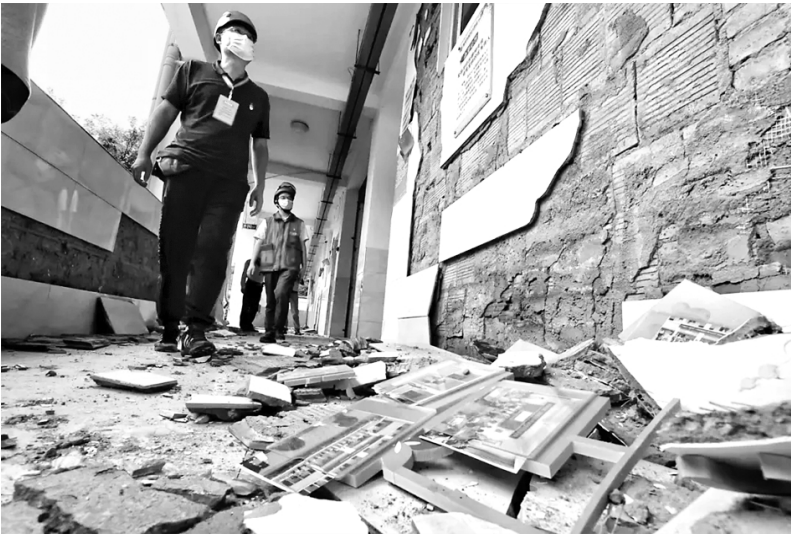
图为救援人员开展震后地质灾害隐患排查。
