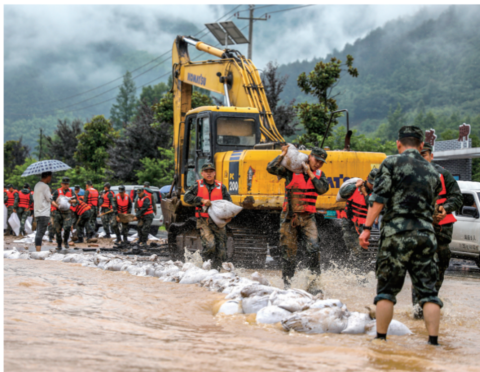
图为武警官兵正在构建引流堤。
