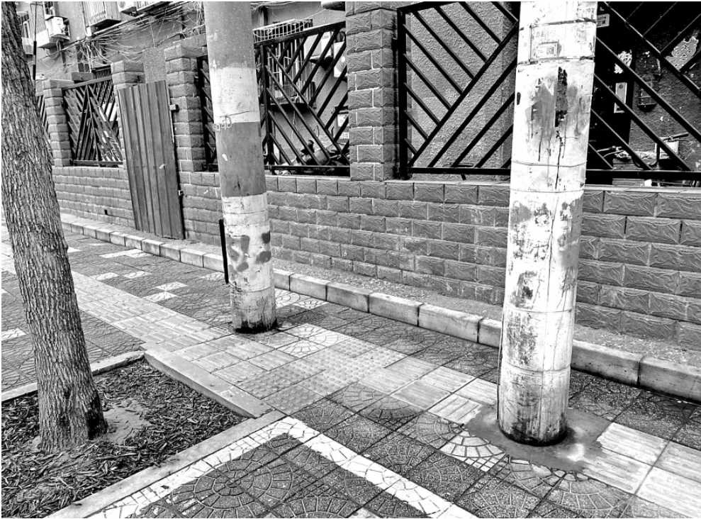
北京市朝阳区曙光西路旁边的道路上，盲道被电线杆从中间截断。
